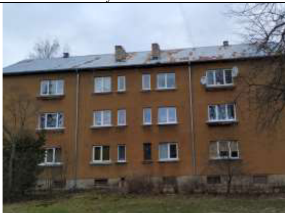
4.att. Ēkas DA fasāde iekšpagalmā.
