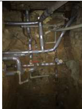
16.att. Nepieciešams sakārtot siltumizolāciju. Attēlā redzamā izolācija paredzēta aukstā ūdens cauruļvadiem (pret kondensācijas izolācija).
