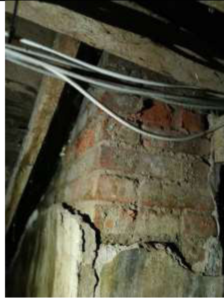
22.att. gandrīz gar visiem ventilācijas kanāliem novērota nopietna lietusūdens iekļūšana ēkā. Ventilācijas kanāliem bojāts ne tikai apmetums, bet arī ķieģeļiem ir samazināta nestspēja – tie drūp.
