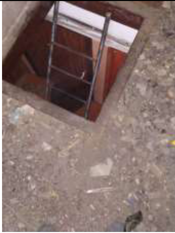
13.att. Ēkas bēniņu grīda ir siltināta ar izdedžu slāni.
