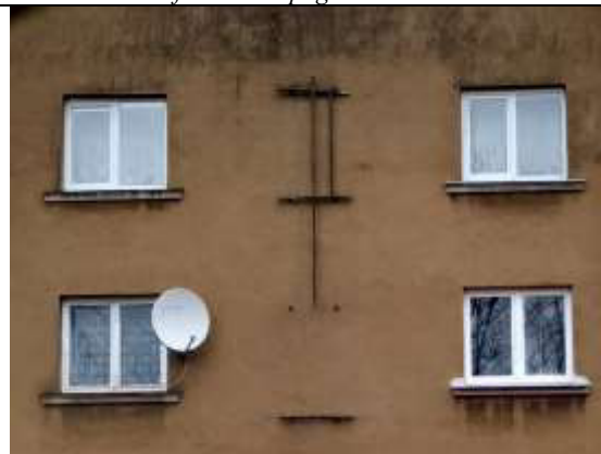
5.att. Lielākā daļa ēkas logu ir nomainīti ar divstiklu pakešu logiem PVC rāmī, atsevišķos dzīvokļos ir arī trīsstiklu logi PVC rāmī, atsevišķi logi nav mainīti.
