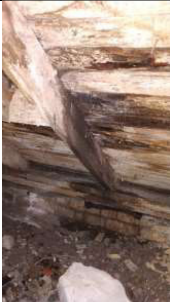
21.att. Jumta segums ir nopietni bojāts, kas bojā arī jumta nesošās konstrukcijas! Obligāti jāveic jumta seguma nomaina un nesošo konstrukciju tehniskā apsekošana
