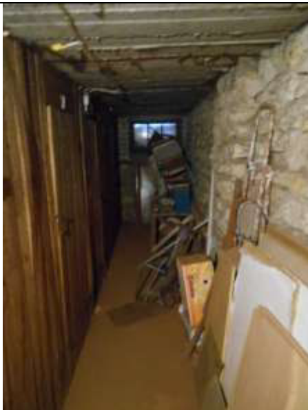
17.att. Ēkas pamati veidoti no akmens mūra
