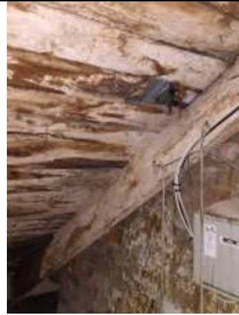
14.att. Ēkas jumta iekšpusē konstrukcijas ir bojātas. Nepieciešams veikt tehnisko apsekošanu. Nav pieļaujama siltumizolācijas uzklāšana bēniņu grīdai, kad bojātas jumta konstrukcijas.
