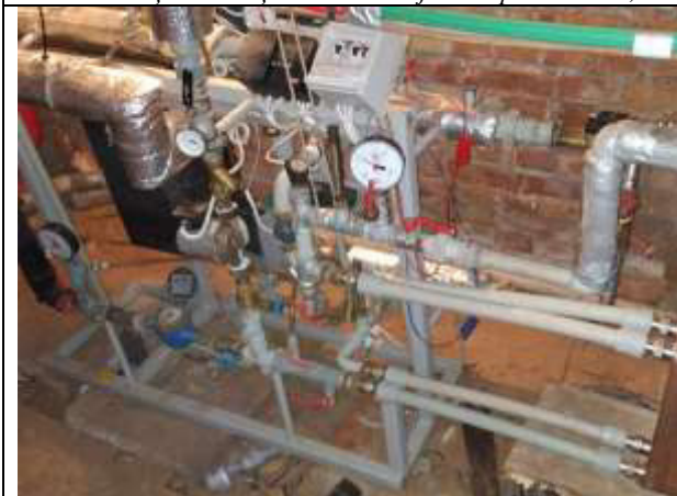
7.att. Ēkas neatkarīga pieslēguma siltummezgls.
