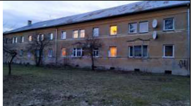
3.att. Ēkas DA fasāde.
