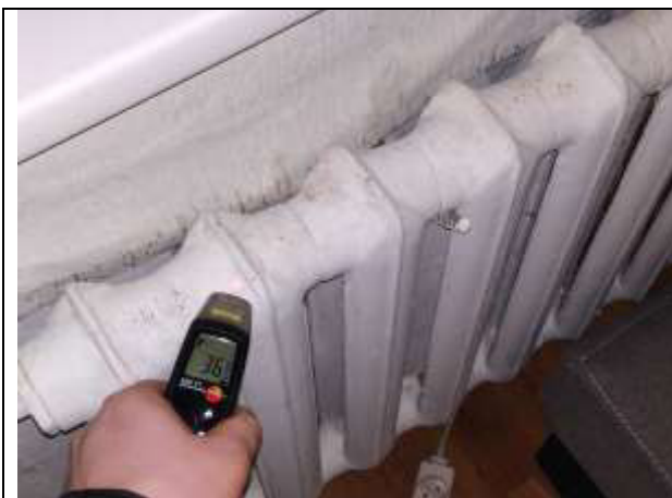
6.att. Atsevišķos dzīvokļos ir uzstādīti jaunā tipa radiatori, bet daļā ir saglabājušies vecie sildķermeņi. Viencauruļu sistēma
