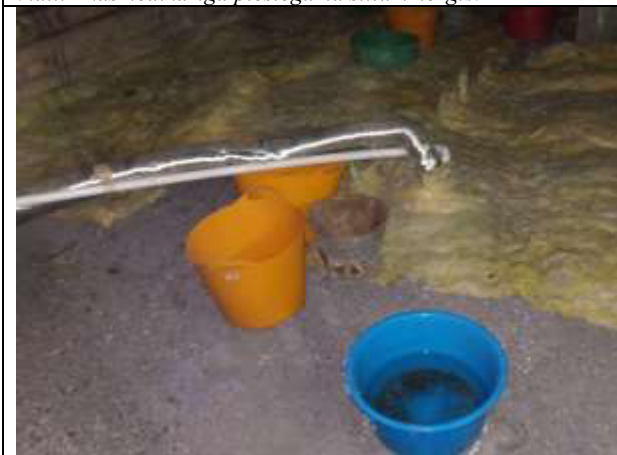
9.att. Ēkas bēniņu grīda ir siltināta ar izdedžiem un atsevišķās vietās arī ar minerālvati. Ēkas iedzīvotāji uzlikuši spaiņus, lai savāktu lietus ūdeni, kas iekļūst caur jumta bojājumiem. Nepieciešams veikt tehnisko apsekošanu. Nav pieļaujama bēniņu siltinājuma uzlabošana pirms nav salabots jumta segums.
