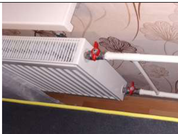
6.att. Atsevišķos dzīvokļos ir uzstādīti jaunā tipa radiatori, bet daļā ir saglabājušies vecie sildķermeņi. Viencauruļu sistēma
