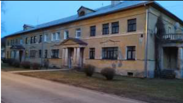
2.att. Ēkas ZR fasāde.
