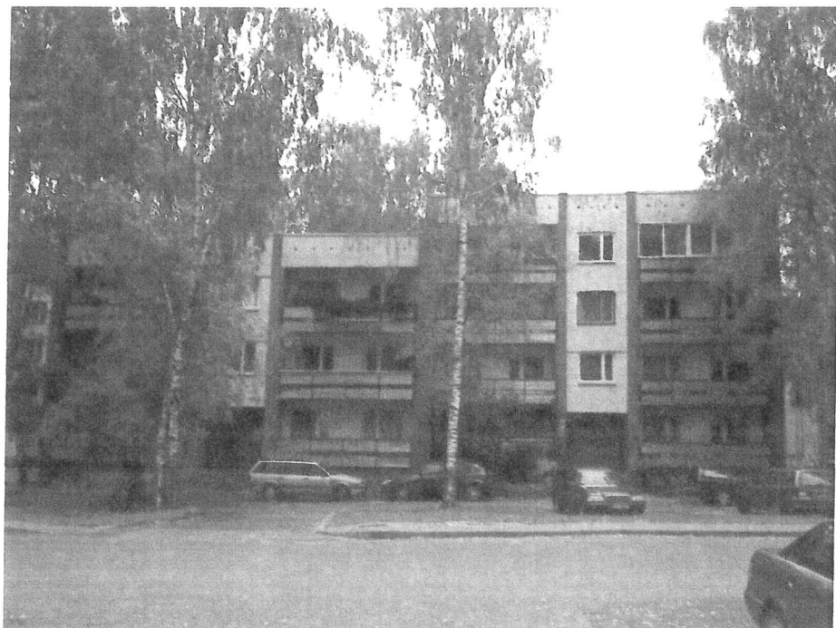
4.attēls. Kopskats uz ēkas fasādi, vienai kāpņu telpai 3, otrai 4 stāvi.
