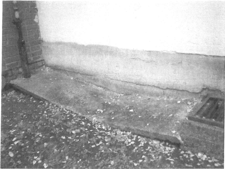
3.attēls. Bojāta ēkas betona apmale. Siltinot cokolu betona apmale tiks atjaunota.
