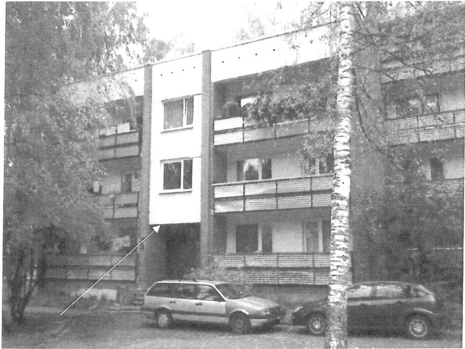
1.attēls. Pārsegums, ko nepieciešams papildus siltināt, lai nodrošināt komfortu 2.stāva dzīvokļos virs ieejas kāpņu telpās.
